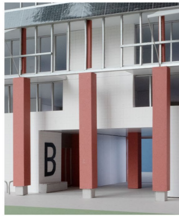
Durchgang- und Eingangssituation
